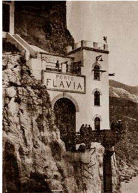
Il sito minerario di **Porto Flavia** prese il nome dalla primogenita del progettista, l'Ing. Vecelli e fu realizzata nel 1924 scavando nella montagna calcarea due gallerie sovrapposte intervallate da 9 silos.
